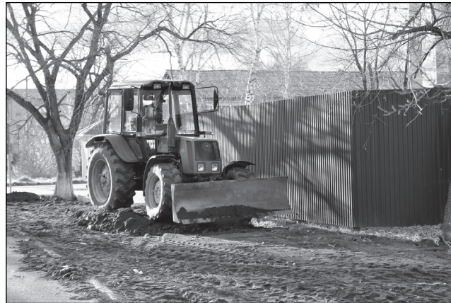
Работы на ул. Партизанская
