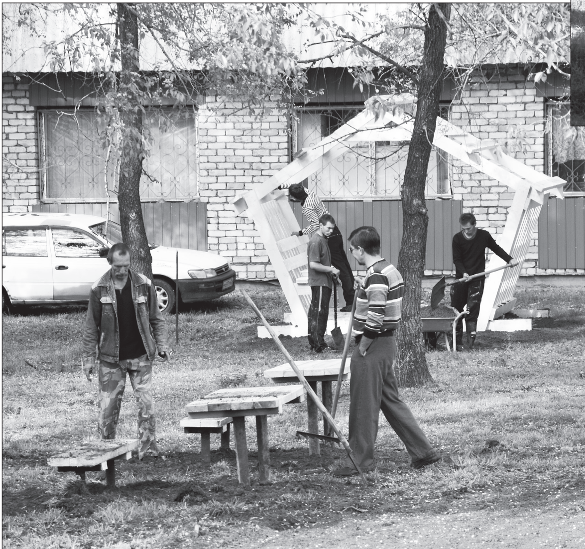
Завершаются работы на игровой площадке.
