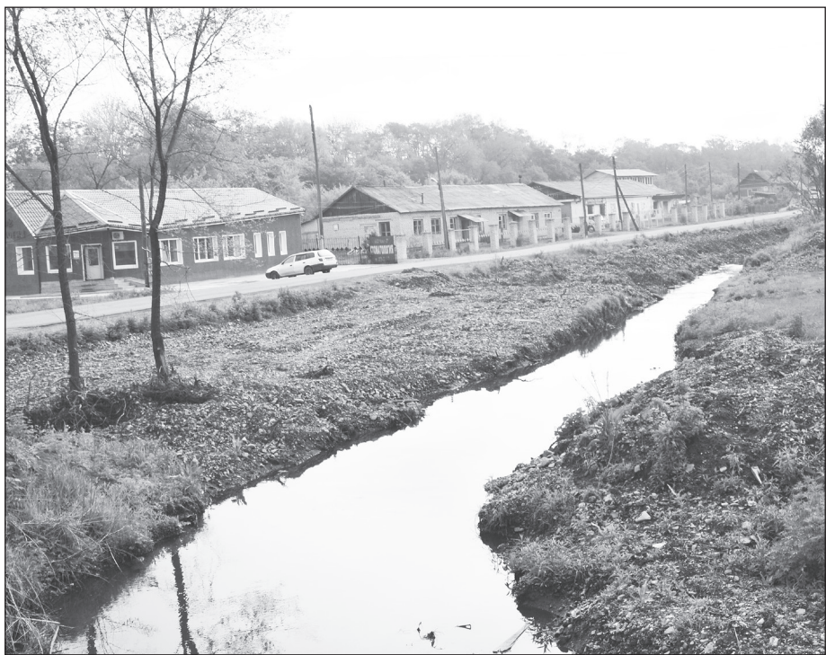
Расчищенный и углубленный ручей на ул.Пугачева с одной стороны моста...
