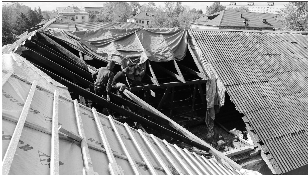
Во время капремонта скатных кровель должна проводиться и огнебиозащитная обработка.
