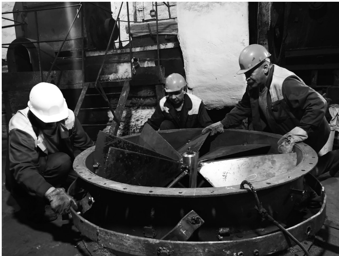
Идет ремонт оборудования в Спасском филиале «Примтеплоэнерго».
