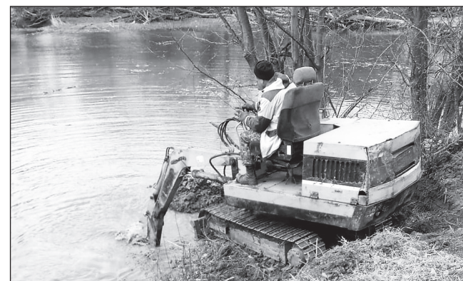
Расчистка и углубление летнего водозабора в с. Варпаховка
