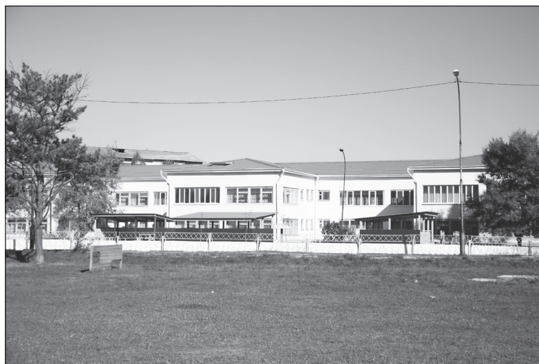
Детский сад №37 после ремонта
