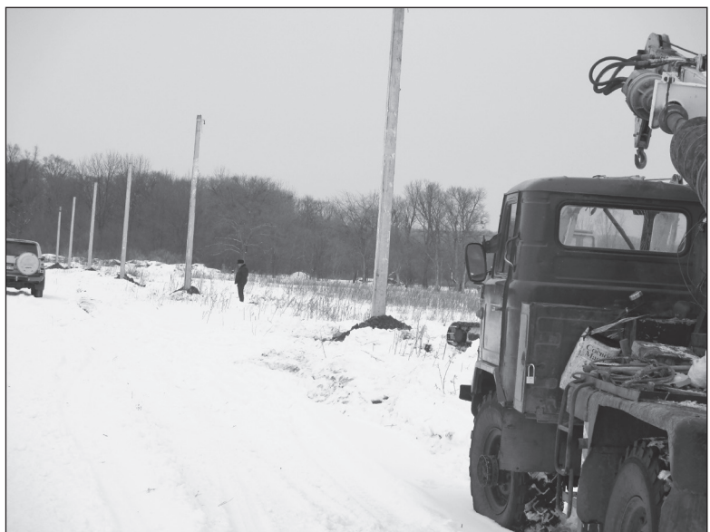
Установка столбов уличного освещения на ул. Лесной
