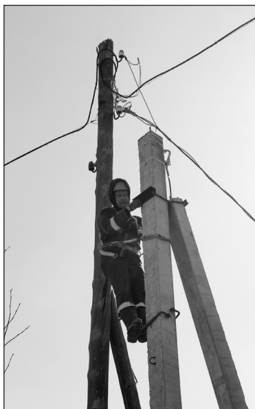
В Чугуевке и Шумном выполнены работы по устройству уличного освещения
