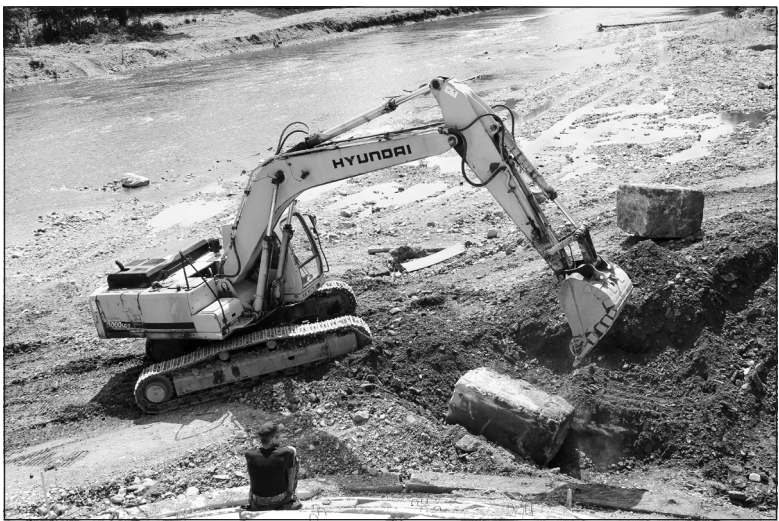
Ремонт моста, поврежденного в результате паводка
