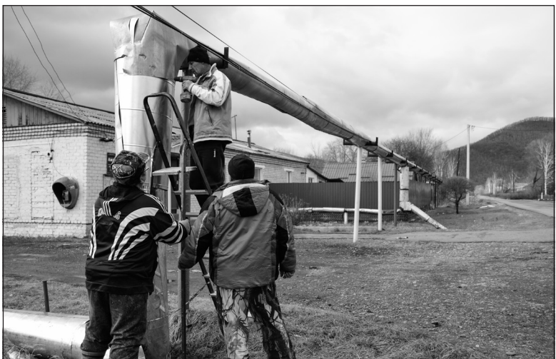
Ремонт воздушной водопроводной сети в Цветковке
