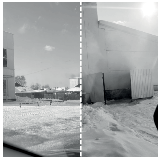
Проведены работы по уборке снега и ограждению места по сбору мусора возле магазина Family City
