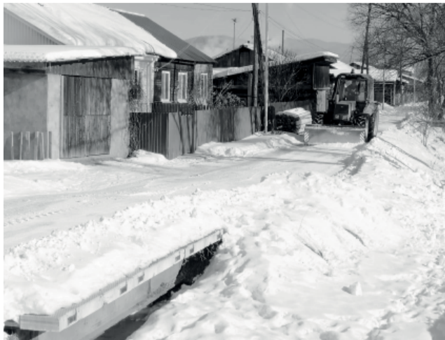
Практически сразу после обращения граждан на 1-й Набережной начались работы по очистке улицы от снега
